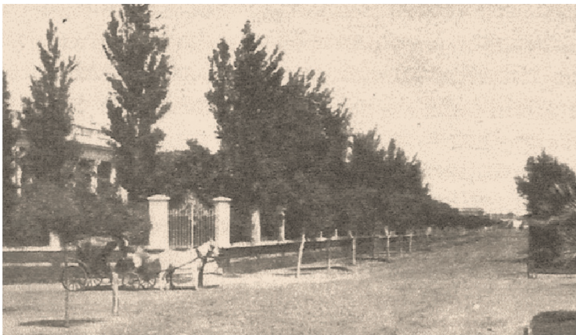
Boulevard Gálvez esquina Las Heras
