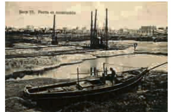
VISTA del Puerto en construcción. Tarjeta postal, colección Graciela Hornia. FOTO: BANCO FLORIÁN PAUCKE / AGPSF
