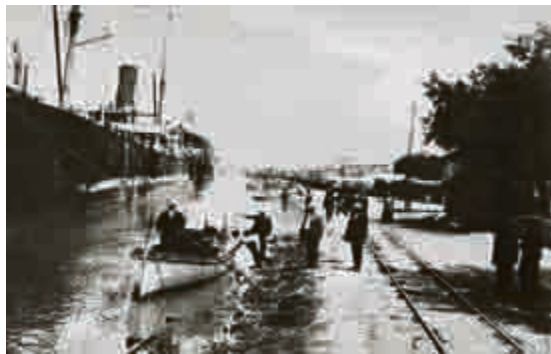
CONFLUENCIA de medios de transporte en el Puerto de Colastiné Sur, Galpones y vías de Ángel Cassanello y Cía en 1904. FOTO: BANCO FLORIÁN PAUCKE / AGPSF
